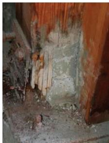
写真 4.2.4.2 金物の結露による腐朽
