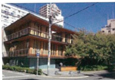
写真-3 燃え止まり型耐火建築物（ルートA）
