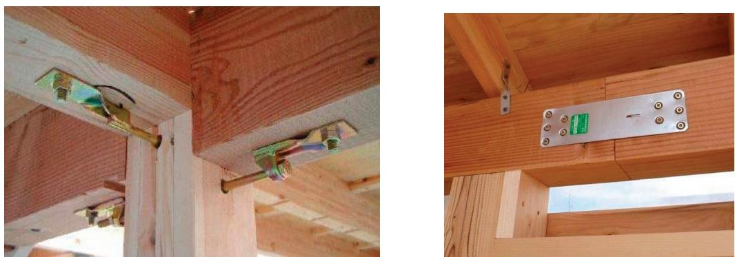
写真 4.2.3.16 左: 羽子板ボルト (片引きと両引きタイプ)、右: 短冊金物 (ビス止めタイプ)
