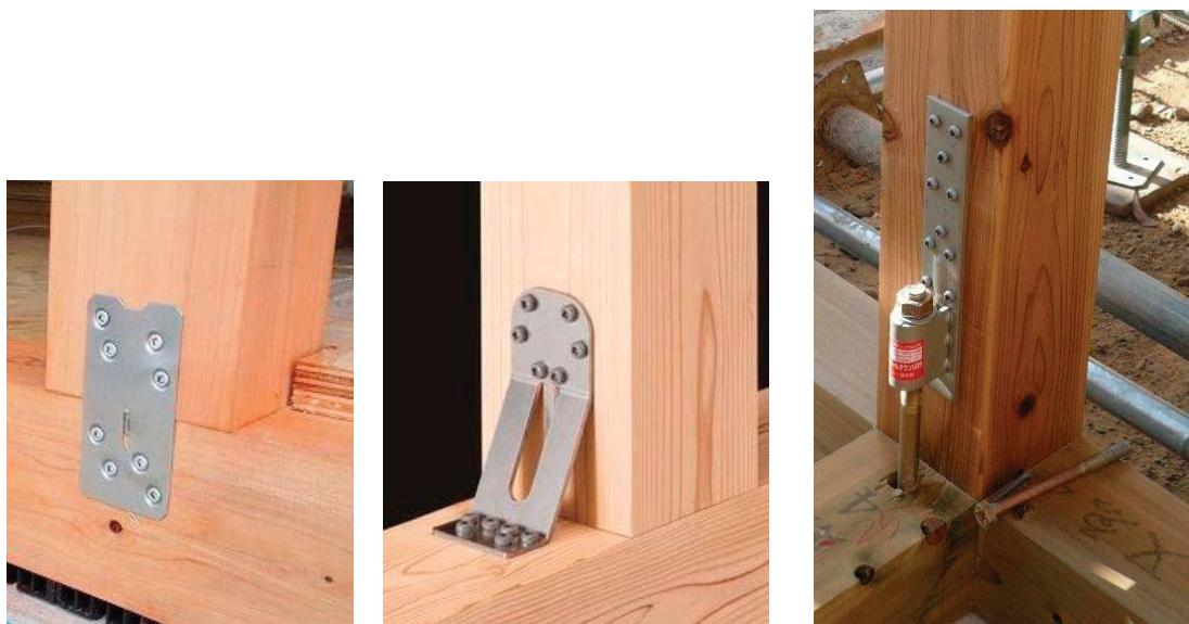
写真 4.2.3.15 柱脚柱頭金物: 左から外付けタイプ、コーナータイプ、ホールダウン金物
