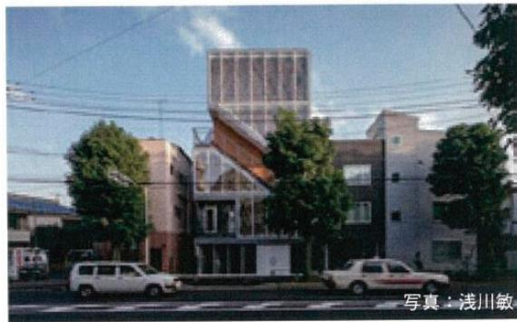
写真-2 5階建て木造共同住宅（1階は鉄筋コンクリート造）
