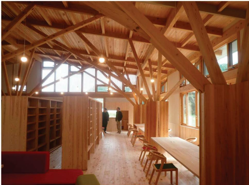
**愛農高校 森館** 三重県産のスギ製材とJパネルを用いた樹状方杖柱構造
