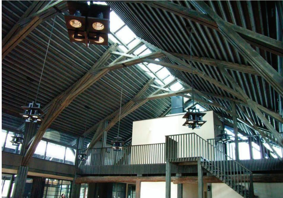
スギ105角2～4本を35mm隙間をあけて並べ、継手・仕口は17.5mmずつ相欠きし、ボルト締めした接合によるトラス
