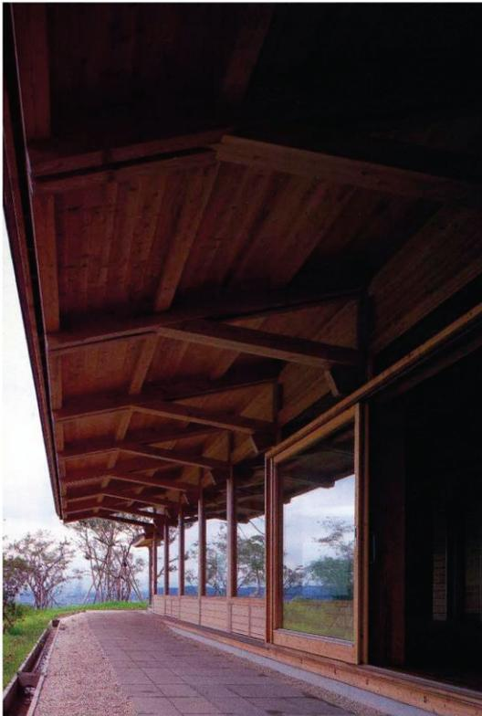
梁間方向:方杖トラス構造
