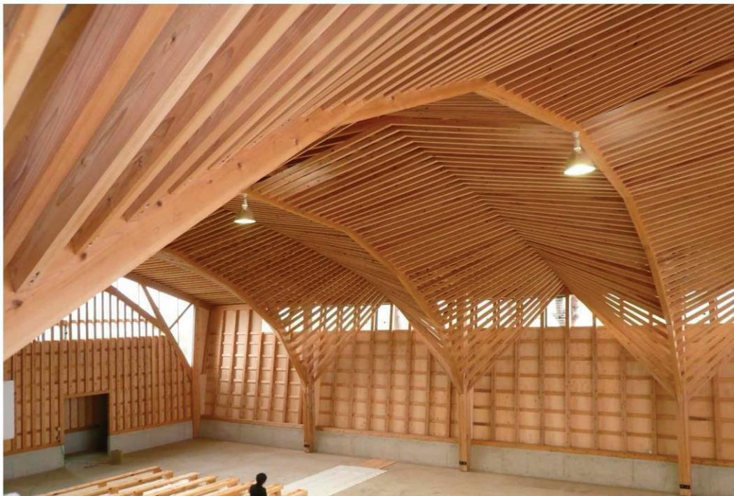
長野県産スギ製材だけを用い、地場の大工・工務店だけで加工・施工を行った大規模木造
