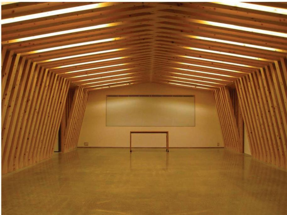
隣接する講義棟の1階講義室は、ヒノキ角材を交互にトラスが形成されるようずらして重ねビス接合した木造門型ラーメンによるルーバー状の壁・天井面としている。
