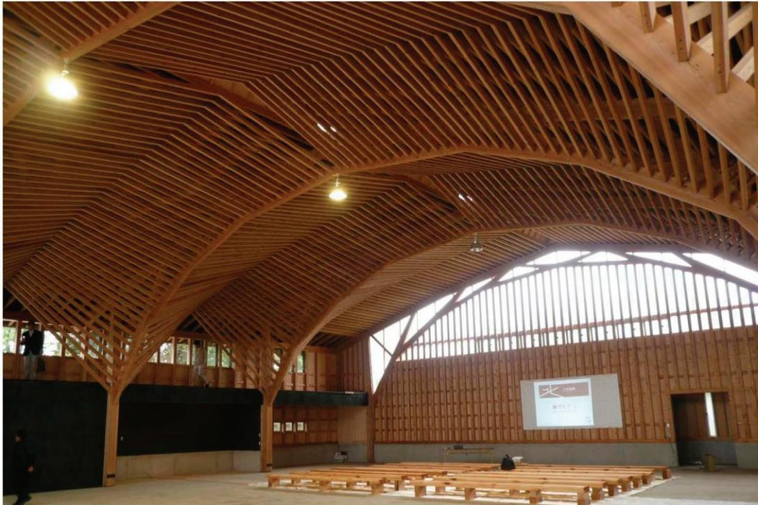
樹状トラス架構＋ルーバー状の方杖・母屋で屋根荷重を分散してアーチ状に軸力伝達した合理的な構造によって、長野県産スギ製材だけで18mスパンの大空間を実現
